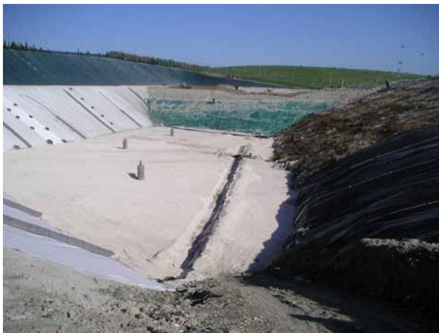
Figura 3 - Il terzo lotto in fase di costruzione
