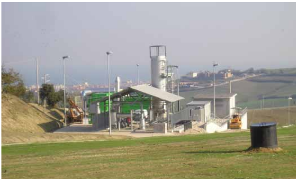
Figura 5 - La centrale di estrazione ed utilizzo energetico del biogas
