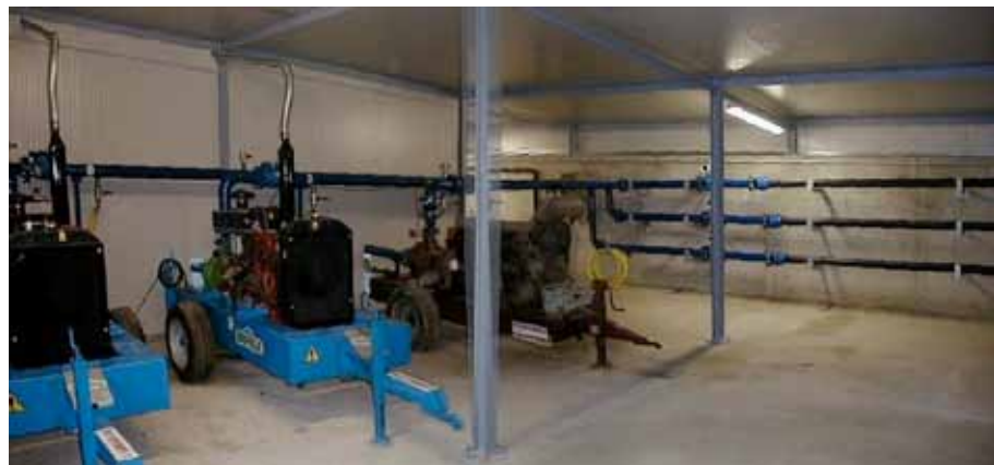
Figura 4 - La stazione di pompaggio del percolato
