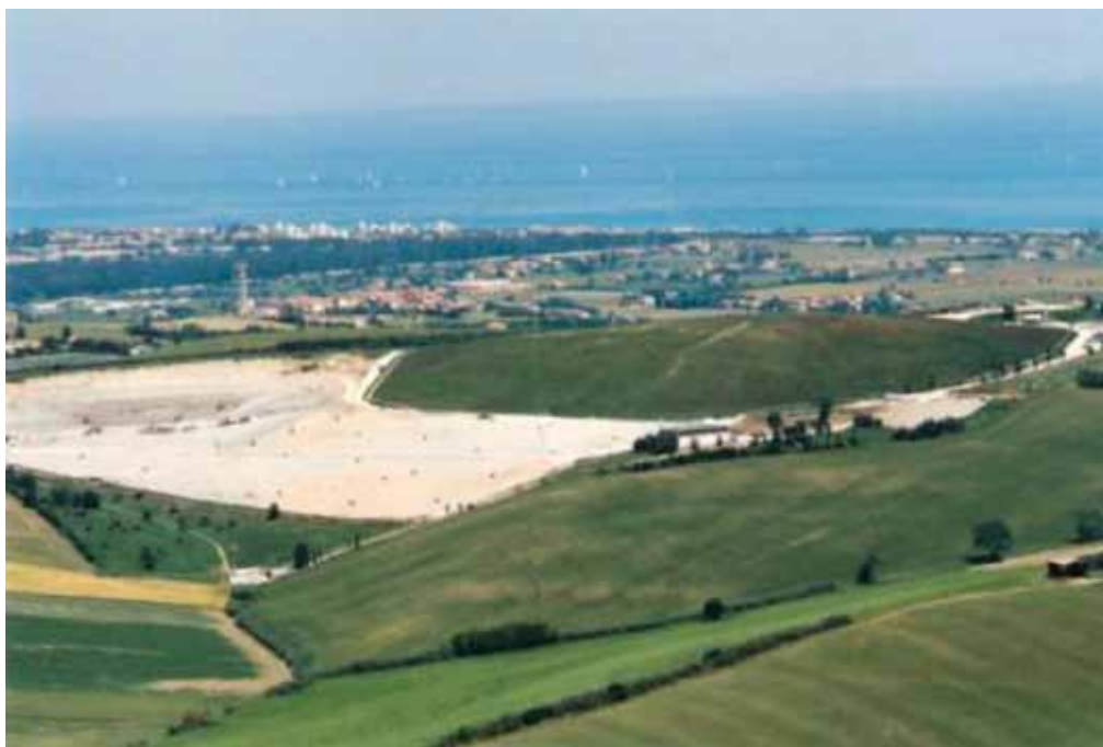
Figura 1 - Vista aerea dell'impianto (Luglio 2007) - Si riconoscono il Bacino 1 (area inerbita) ed il Bacino 2 (lotto in coltivazione)
