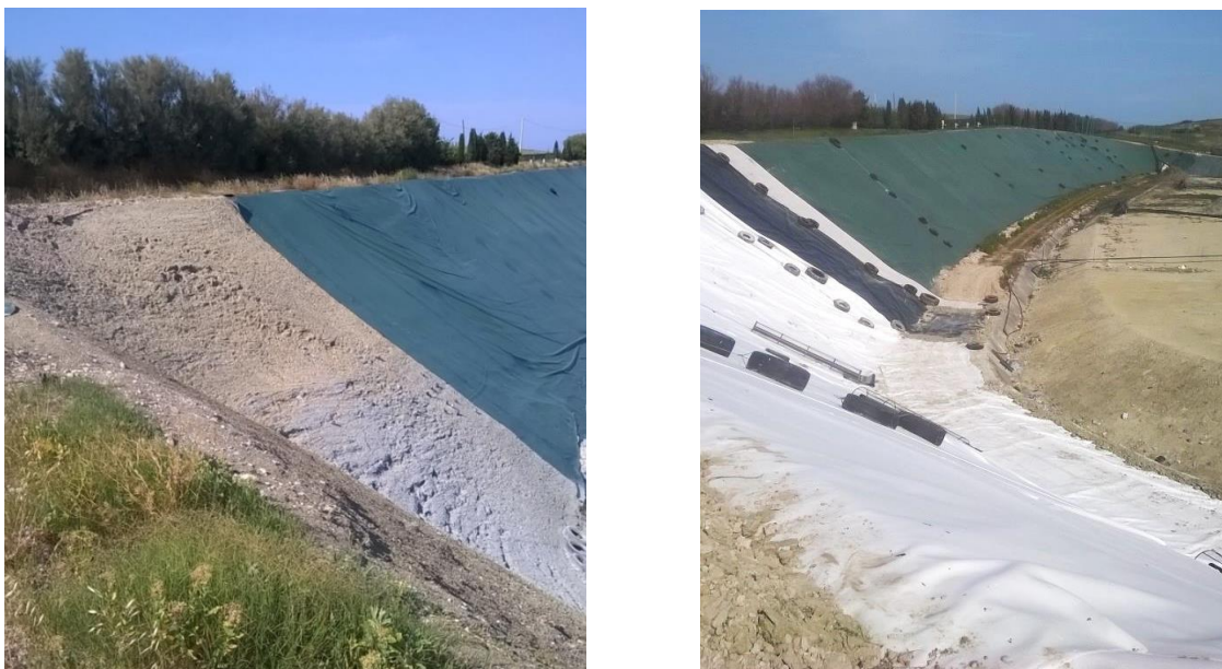
Fig.14: tratto del versante NW risagomato ( 8/2018 ) e successiva sistemazione ( 3/2019 )
